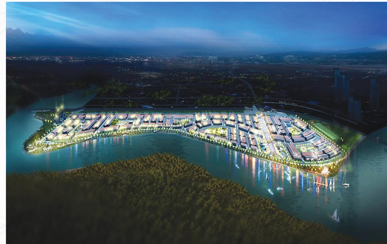
Khu dân cư kết hợp chỉnh trang đô thị Bắc Hà Thanh tại Bình Định
