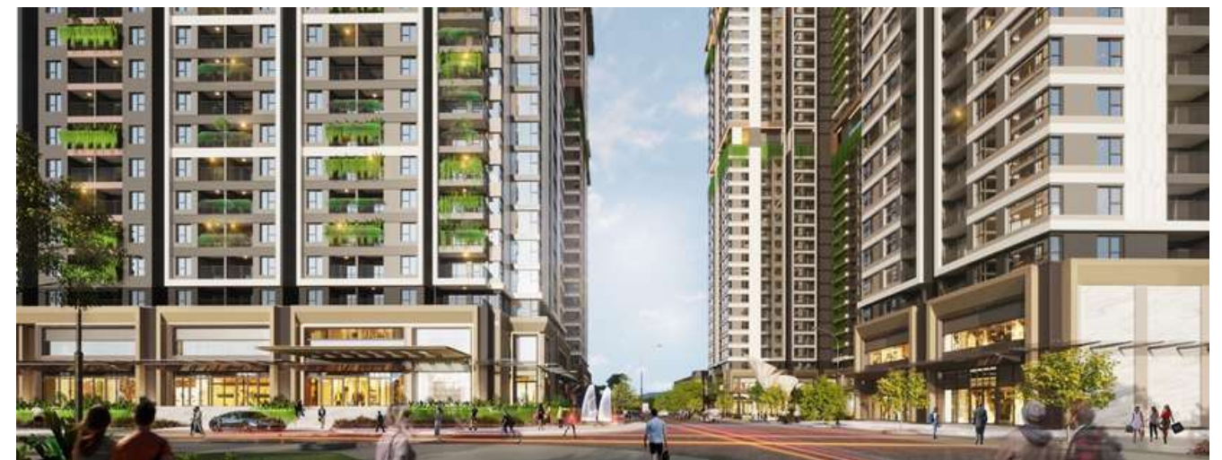
Dự án Thuận An 1&2 đang được Phát Đạt chuẩn bị một kế hoạch tối ưu.
